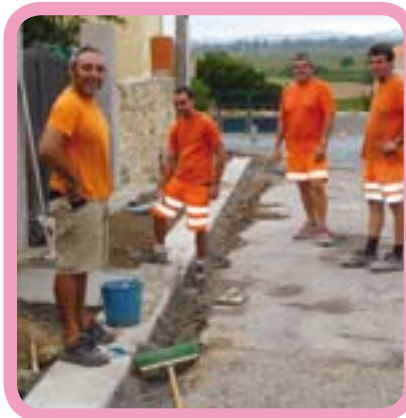
Pendant les travaux
