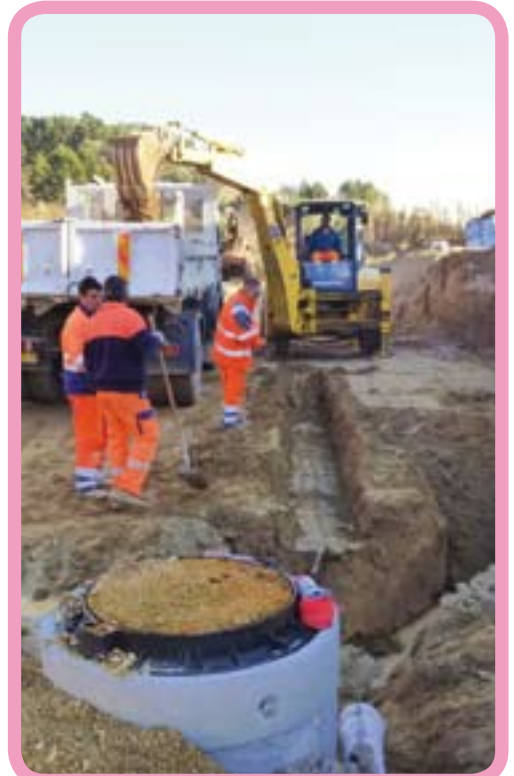
Travaux réalisés par le syndicat de voirie de Ginestas
